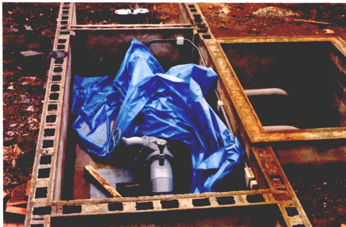
VISTA DE DETALLE
